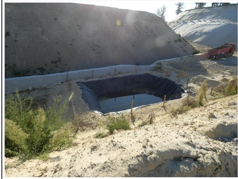
Bassin de collecte des lixiviats (septembre 2023).
