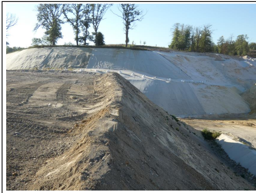
Aménagement des casiers (septembre 2023).
