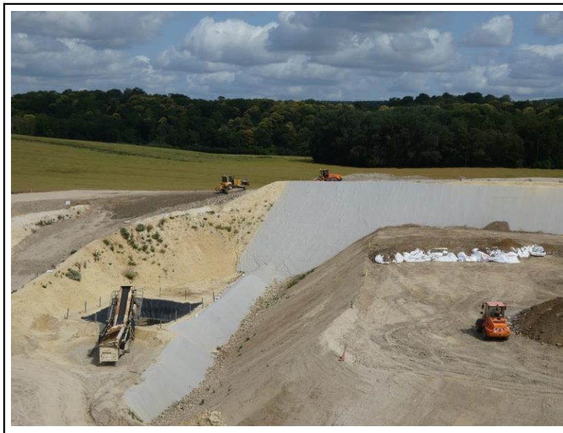
Vue de la digue technique de l'ISDND au Nord du site (juin 2023).
